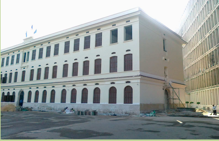
الواجهة الامامية لمبنى الادارة بعد اعمال الدهانات
