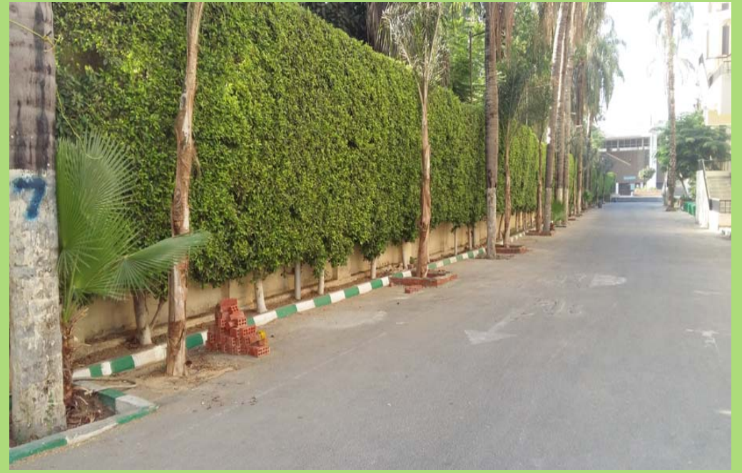
أحواض أشجار النخيل الجديد أثناء أعمال البناء
