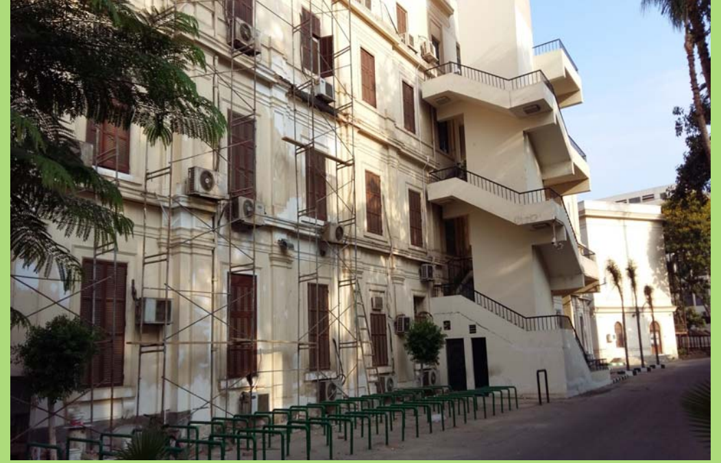
الواجهة الخلفية لمبنى مدني ء اثناء اعمال الاحلال والتجديد
