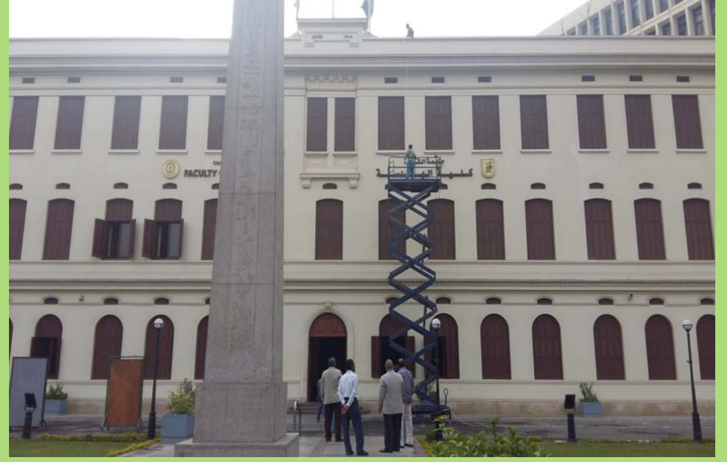
أعمال إزالة العنكبوت والأتربة من واجهة مبنى
