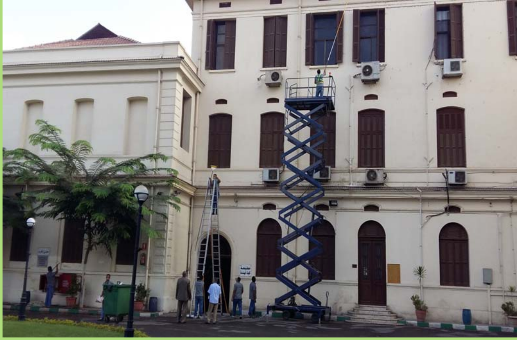
أعمال إزالة العنكبوت والأترية من واجهة مبنى المطبعة
