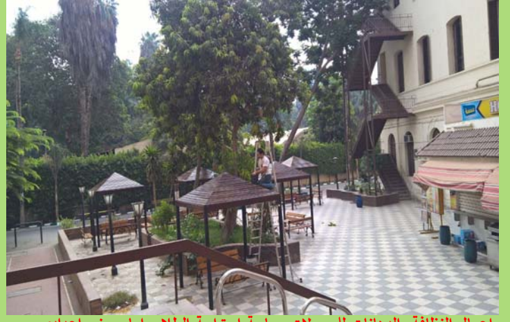
اعمال النظافة والدهانات للبرجولات بساحة استراحة الطلاب امام مبنى اعدادى.
