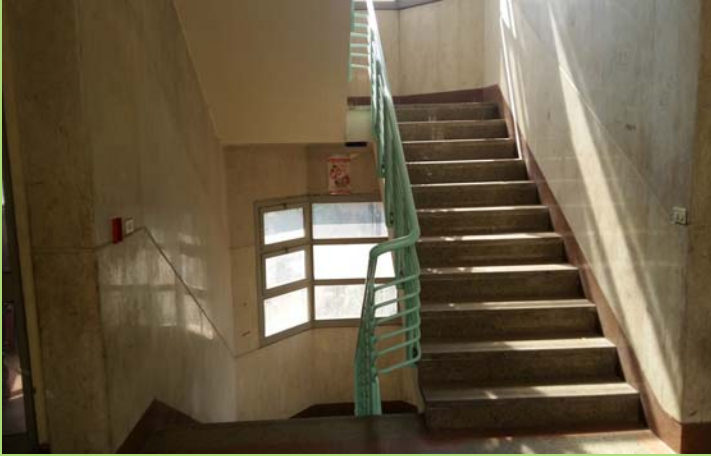
درايزين السلم الرئيسى لمبنى الأنشطة بعد انتهاء أعمال الدهانات
