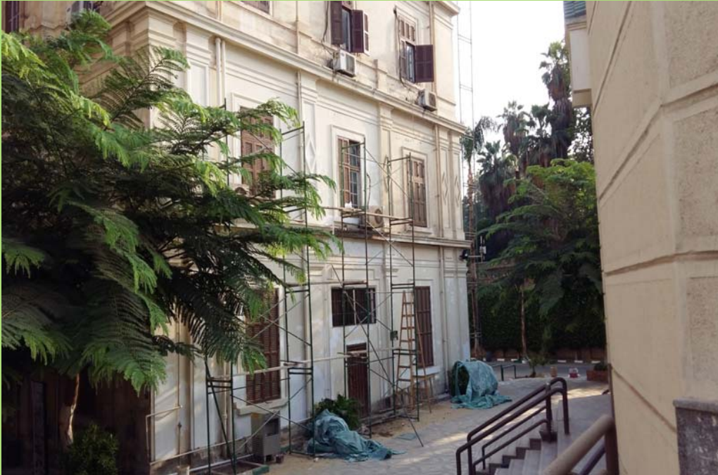
الواجهة الجنوبية لمبنى مدني ء اثناء اعمال الاحلال والتجديد
